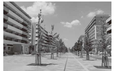
建て替えが進む松原地区
