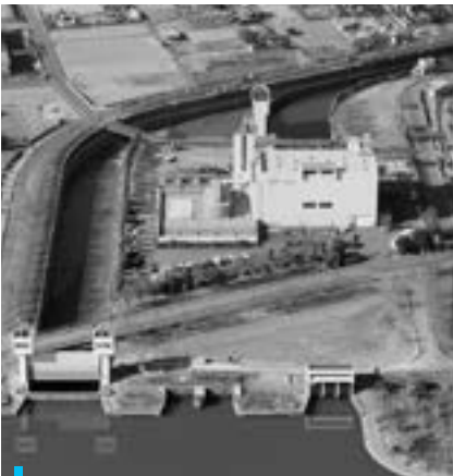
綾瀬川放水路八潮排水機場
