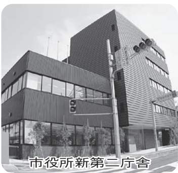
市役所新第二庁舎
