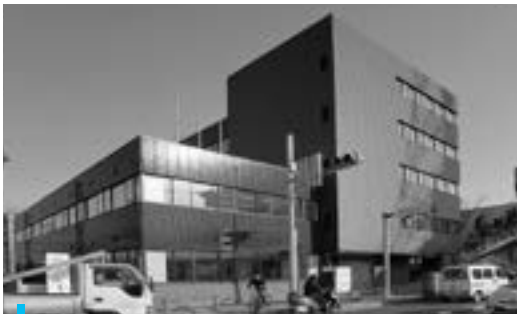
建設が進む市役所第二庁舎
