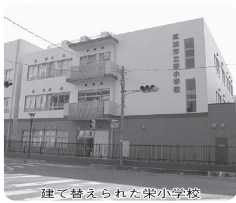
建て替えられた栄小学校
