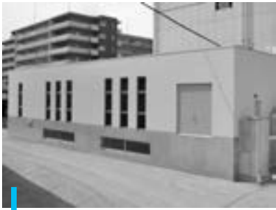
耐震化した吉町浄水場配水ポンプ棟
