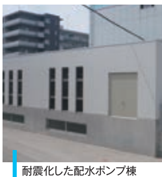
耐震化した配水ポンプ棟
