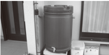
雨水貯留施設
