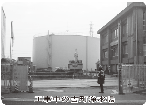
工事中の吉町浄水場
