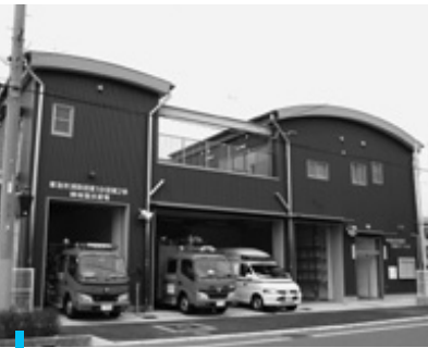
消防署谷塚ステーション
