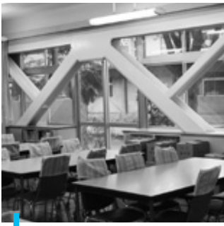
耐震化された校舎
