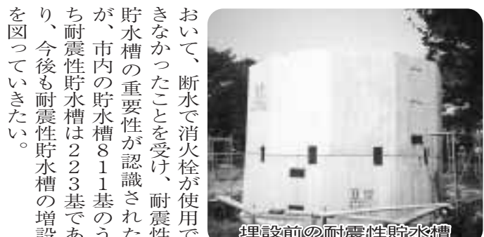
埋設前の耐震性貯水槽
