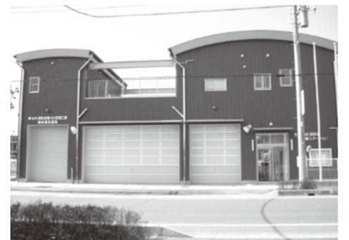
消防署谷塚ステーションは、消防自動車1台、高規格救急自動車1台を配備するほか消防団機械器具置場も併設され、市南部地域の消防力と救急体制の強化を図ります。建物は、鉄骨造の2階建てで、延べ床面積380・91平方メートル。総工事費1億5257万円。
