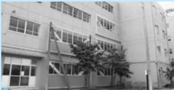
ブレースが設置された氷川小の外観
