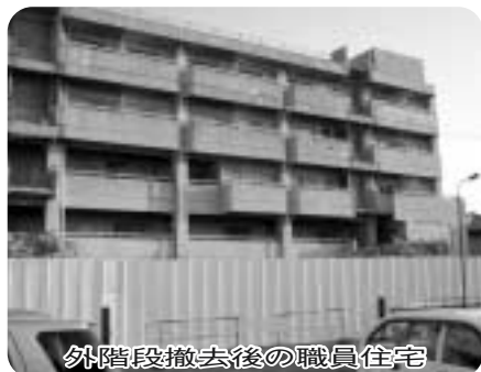
外階段撤去後の職員住宅
