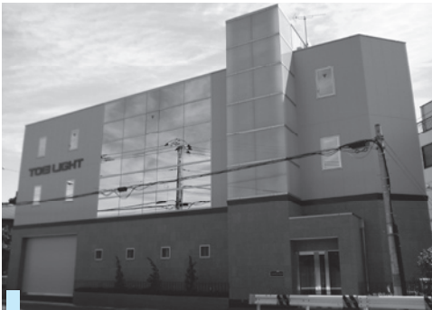
トーエライト㈱社屋(建物景観部門)
