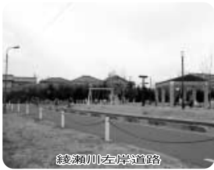
綾瀬川左岸道路
