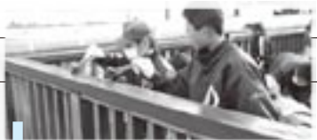
葛西用水人道橋の塗装(29日)
