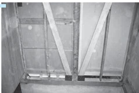
押し入れの奥の柱と柱の間に筋交いを交差して入れ、壁の強度を高めます
