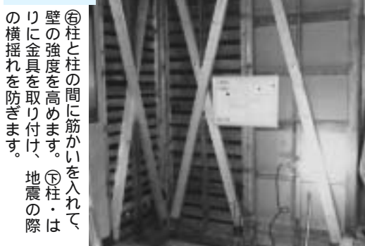
耐震改修工事の一例
