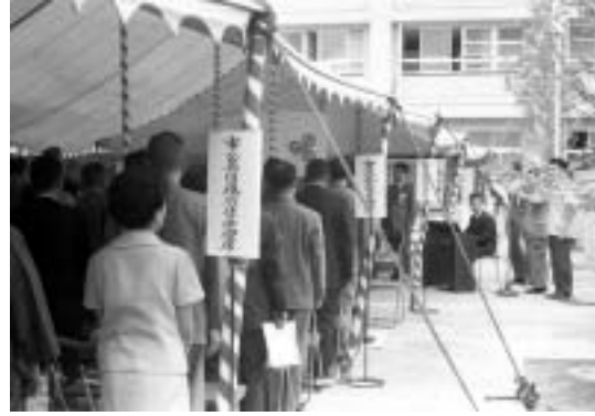
市立病院落成式（昭和42年） 病院の新築工事が完成し、昭和42年6月20日には病院関係者を招き、落成式が行われました。
