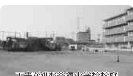
工事が進む谷塚小学校校庭
