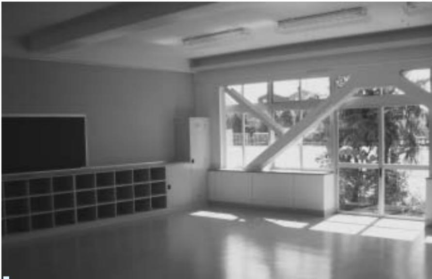
耐震化された新里小(写真右 窓側の鉄骨が耐震補強ブレース)
