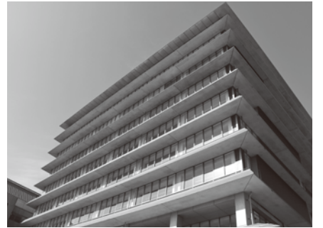
建設がすすむ新庁舎
