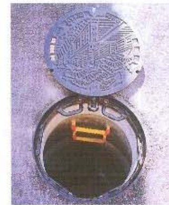
(マンホール設置状況)
