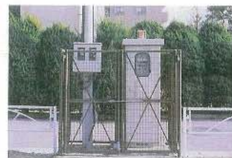
(マンホールポンプ制御盤設置状況)
