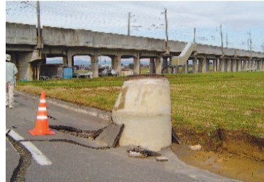
液状化により浮き上がったマンホール(他県)
