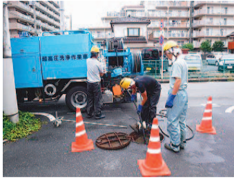
高圧洗浄による清掃作業状況
