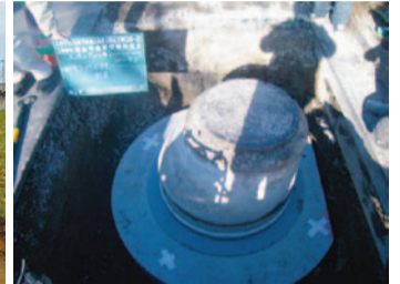
浮き上がり防止のためのブロック設置工事(草加市内)
