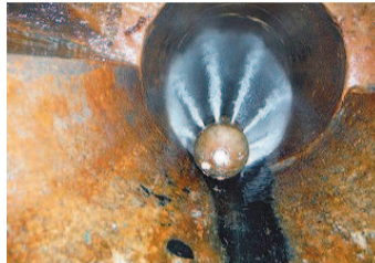
高圧洗浄による管内清掃状況
