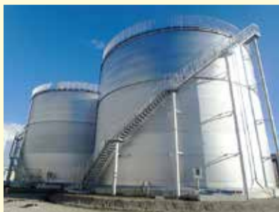
完成した新しい第2配水池
