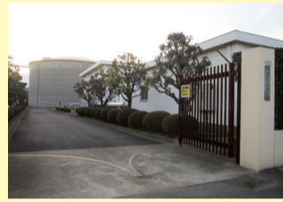
(中根 2-38-24) ※応急給水は可能ですが、耐震化工事中のため入場の際はご注意ください。
