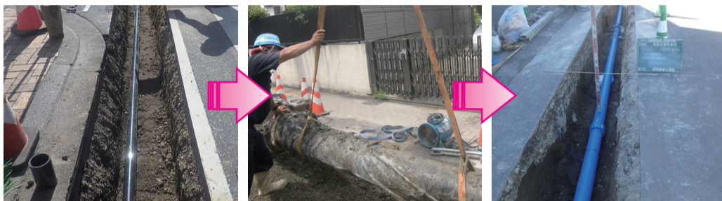
仮の水道管を布設
