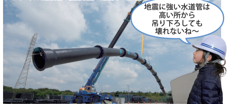
地震に強い水道管の布設
