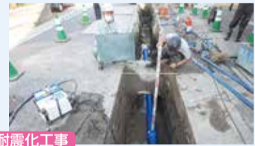
水道管の耐震化工事
