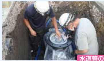
水道管の耐震化工事
