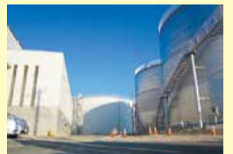
(吉町 4-10-45) ※応急給水は可能ですが、外構工事のため入場の際はご注意ください。
