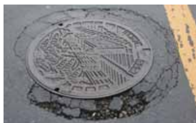
※マンホール周りが破損している状態
