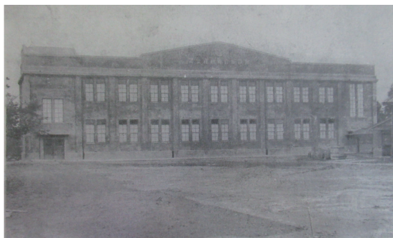
竣工直後の草加小学校西校舎（校庭から見る）
