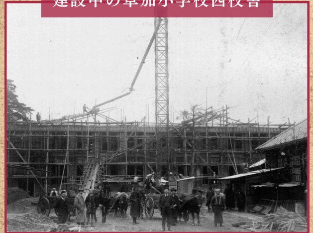
建設中の草加小学校西校舎
