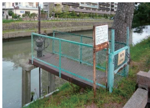
図 2-10 : 旧住宅・都市整備公団樋管 (指定地内より)
