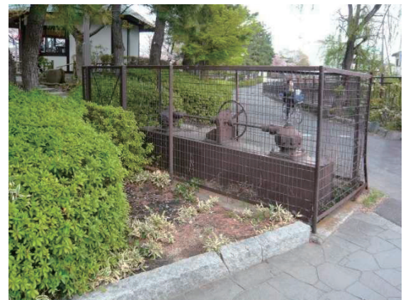
図 2-21 : 佐藤落とし樋管ゲートフェンス
