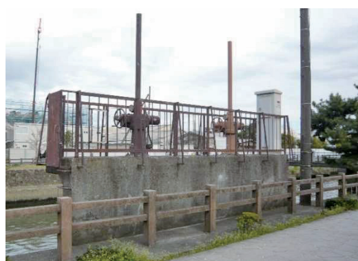
図 2-9 : 三ツ橋排水樋管施設 (指定地内より)
