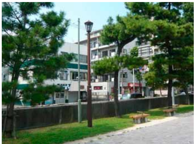
図 6-2：県道側に設置された擁壁
