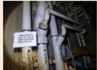
排水配管に発錆(B評価)
