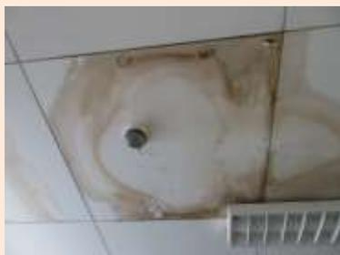
天井漏水痕(C評価)
