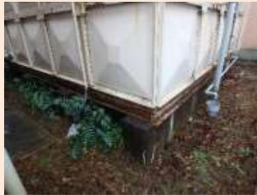
受水槽架台に発錆(C評価)
