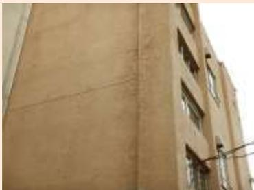
外壁塗装の膨れ(B評価)
