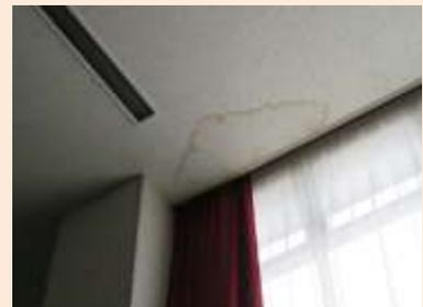
天井漏水痕(C評価)
