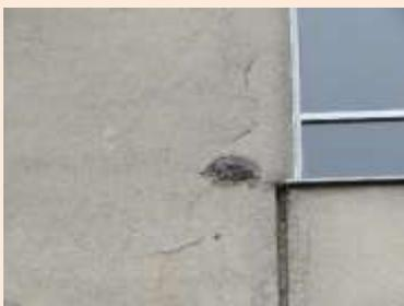
外壁の剥落(C評価)
