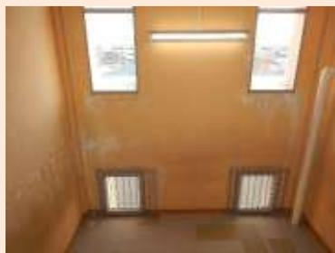
内壁漏水痕(C評価)
