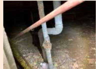
プール下配管の破損(D評価)
