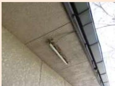
照明器具カバーの破損(B評価)
