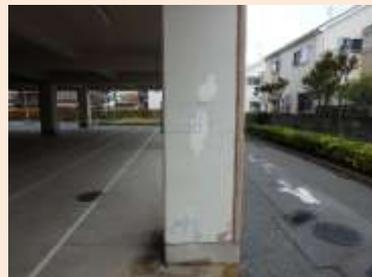
外壁塗装の膨れ(B評価)
