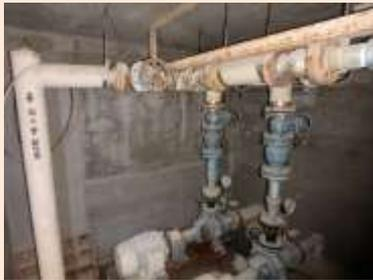
給水配管に発錆(C評価)
