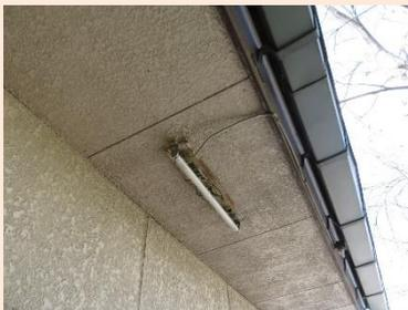
照明器具カバーの破損(B評価)
