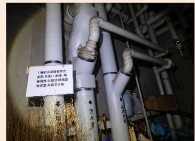
排水配管に発錆(B評価)
