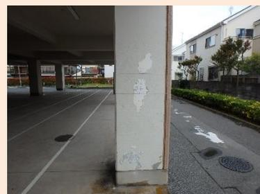
外壁塗装の膨れ(B評価)
