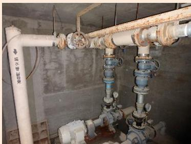
給水配管に発錆(C評価)
