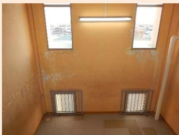
内壁漏水痕(C評価)
