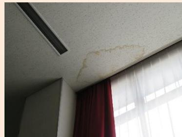
天井漏水痕(C評価)
