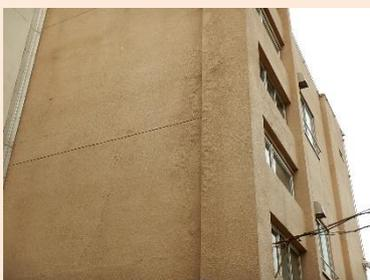
外壁塗装の膨れ(B評価)
