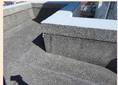
屋上保護モルタルのひび割れ(B評価)
