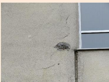
外壁の剥落(C評価)
