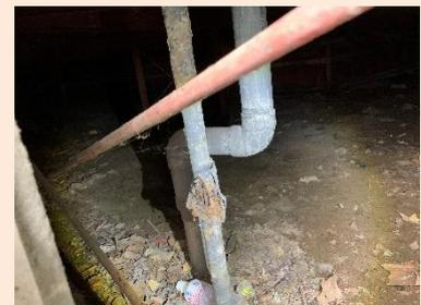
プール下配管の破損(D評価)
