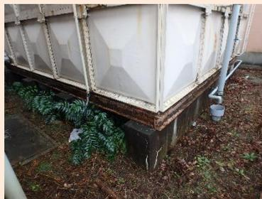
受水槽架台に発錆(C評価)
