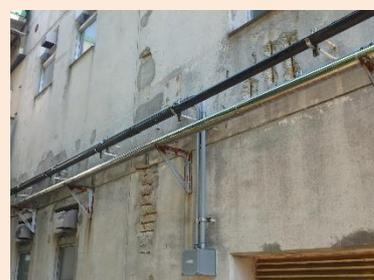
鉄筋の露出(D評価)
