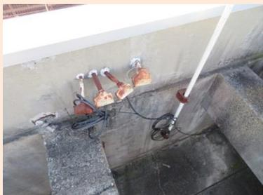
配線引き込みカバーの発錆(C評価)
