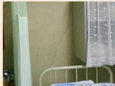
壁面のひび割れ(B評価)
