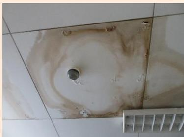
天井漏水痕(C評価)
