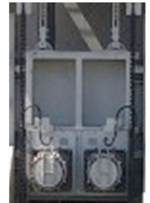
ポンプ設置状況
