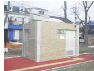
多目的トイレ
