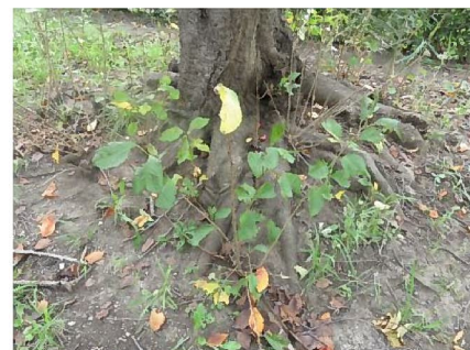
目立つ露出根やひこばえ 露出根は根が地下に十分に張れないために生じる
