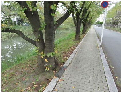
狭い植栽帯 桜が歩道の縁石に接触し腐朽
