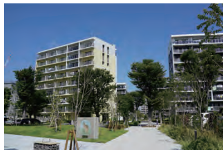
建て替えられた草加松原団地 (松原 2 丁目)
