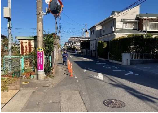
歩道が狭くなっている箇所
