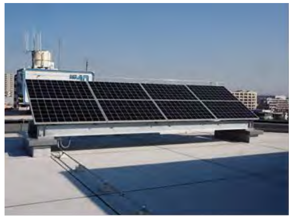
■ 市役所第二庁舎屋上
