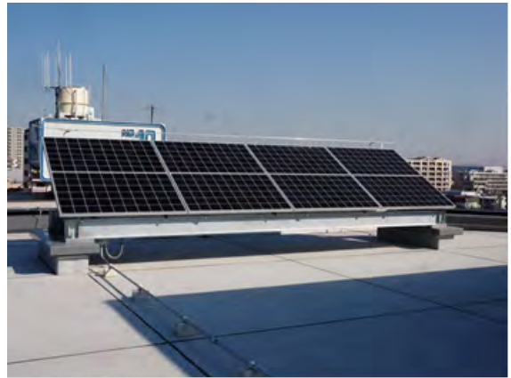
■ 市役所第二庁舎屋上
