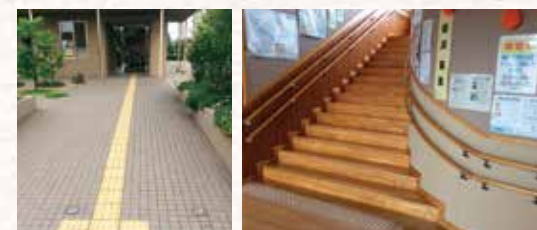
▲二段あると誰でもつかみやすい手すり
