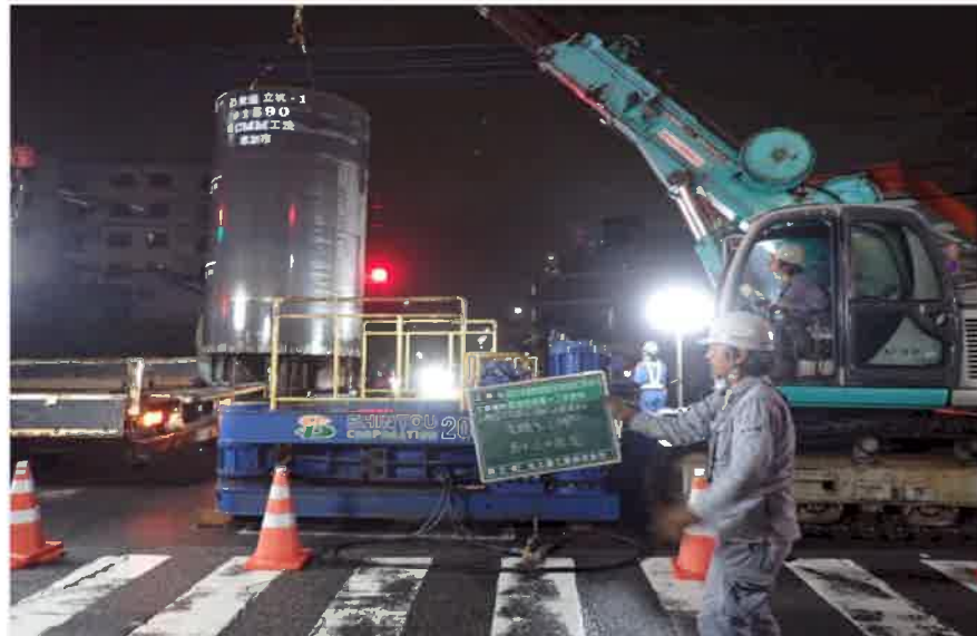
公共下水道第6処理分区污水枝線工事(R6-5)
