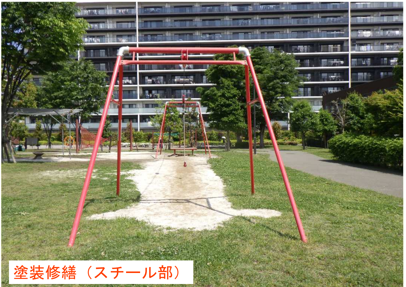
塗裝修繕（スチール部）
