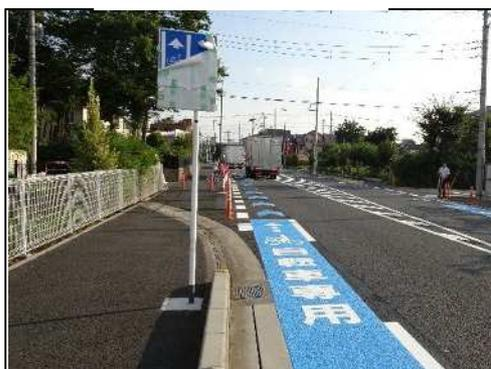
図 4-4 自転車専用通行帯の整備イメージ
