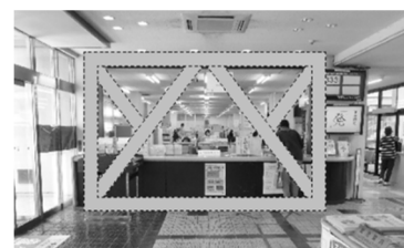
鉄骨ブレース（筋かい）補強後
