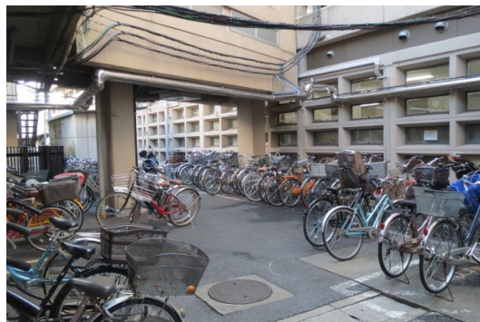
駐輪場の不足
