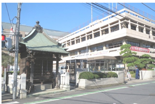
A: 本庁舎 (南東側)
