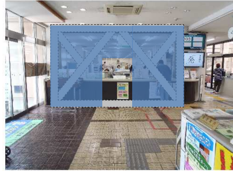
※鉄骨ブレース補強イメージ 市民課 (1F) 【補強後】 (総合窓口)
